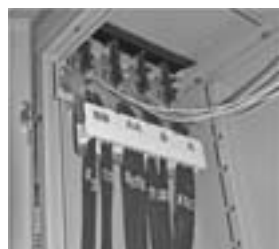
Зона ввода, разделки и фиксации ОК
