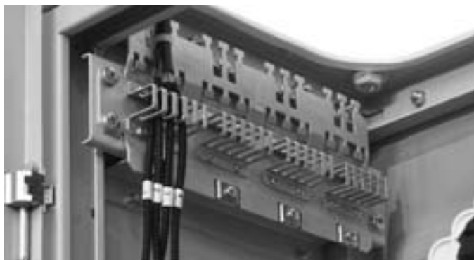
Зона ввода, разделки и фиксации ОК
