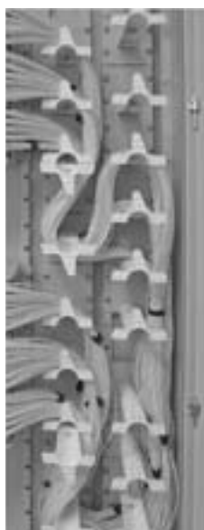
Зона выкладки запаса длины патчкордов
