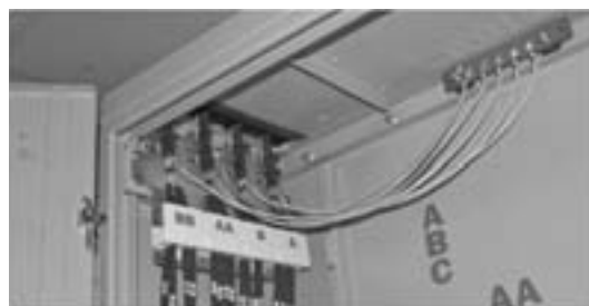
Заземление кабелей
